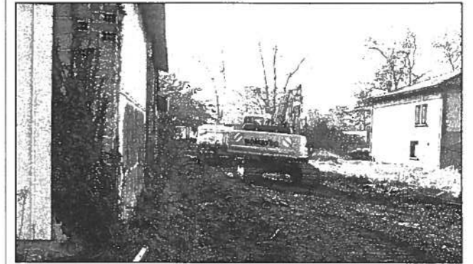
Travaux d'accès au terrain
